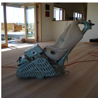
INSTALACIÓN O RESTAURACIÓN DE PARQUETS
